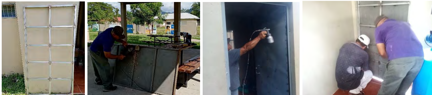
Reparación e instalación de la puerta del cuarto de bombas del parque Alegría en El Progreso, Yoro
