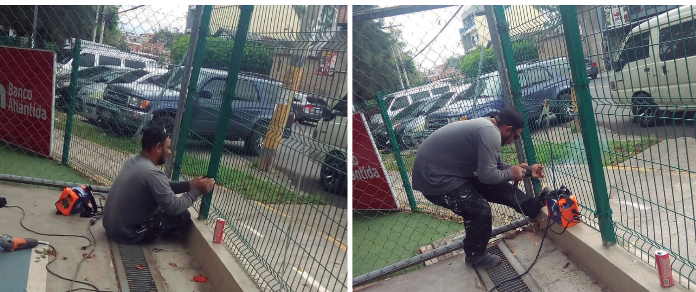
Se repararon algunas mallas del cerco perimetral del Parque El Hogar.
