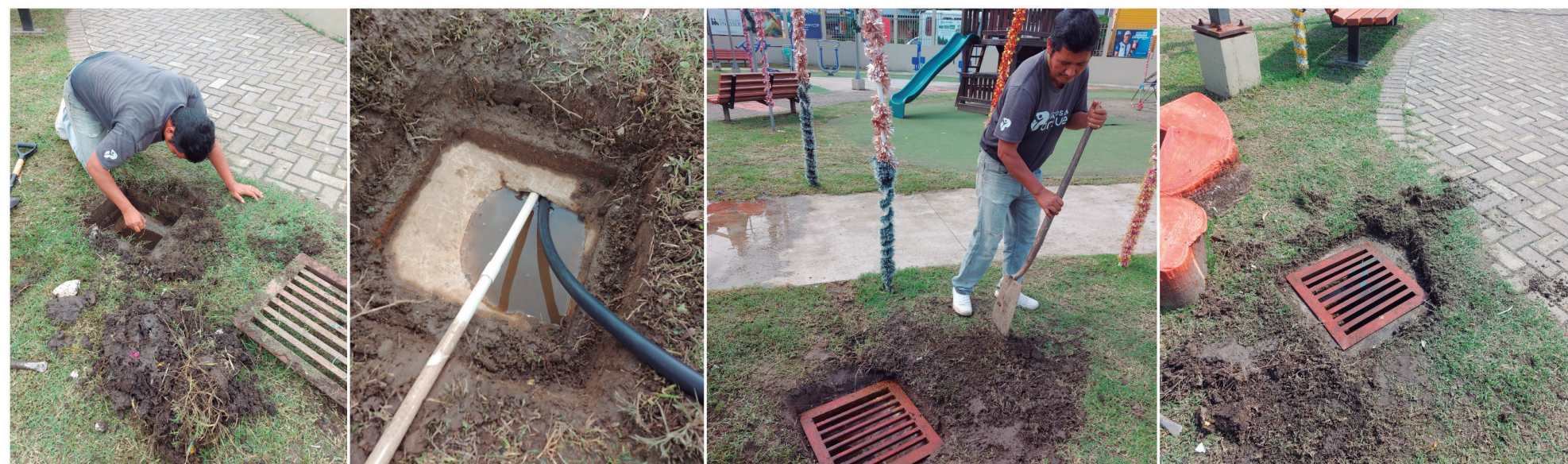
Se ha realizado el mantenimiento de los desagües de aguas lluvias del parque Chamelecón.
