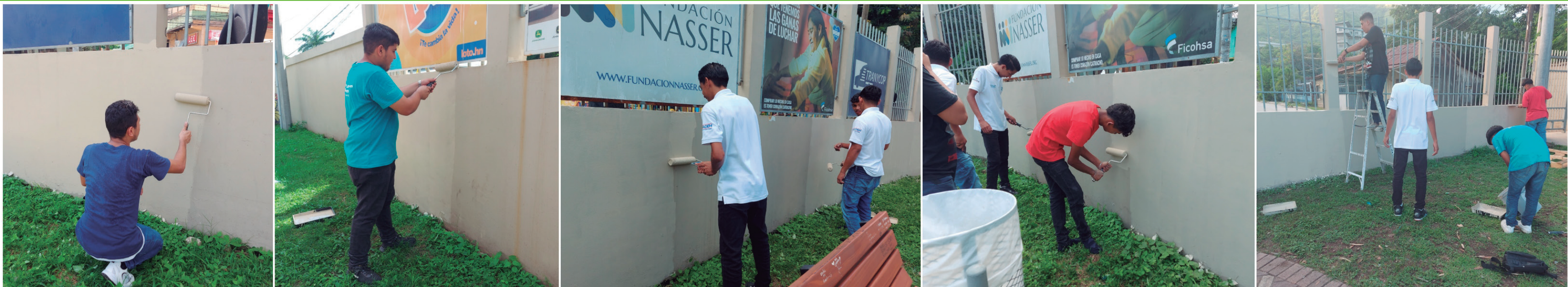
Se ha realizado el lijado y pintado de todo el cerco perimetral, con el apoyo de la comunidad del Parque Chamelecón.
