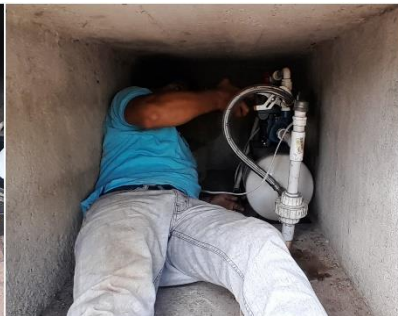
Reparación de llavín y bomba de igual en el Parque San Francisco.
