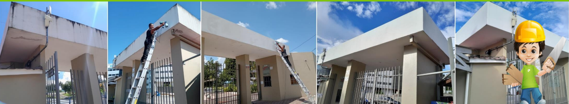
Se ha reparado y pintado el techo del portal de entrada del Parque Solidaridad, El Trapiche.
