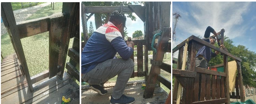
Reparación del single tower en el Parque Chamelecón.
