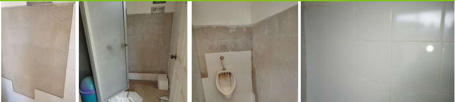
Remoción y pegado de cerámica en área de baños del Parque Chamelecón.
