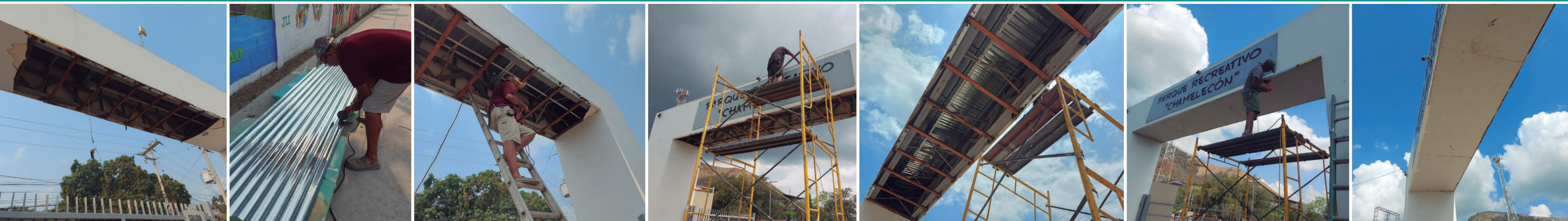
Se ha reparado todo el portal de entrada del Parque Chamelecón.
