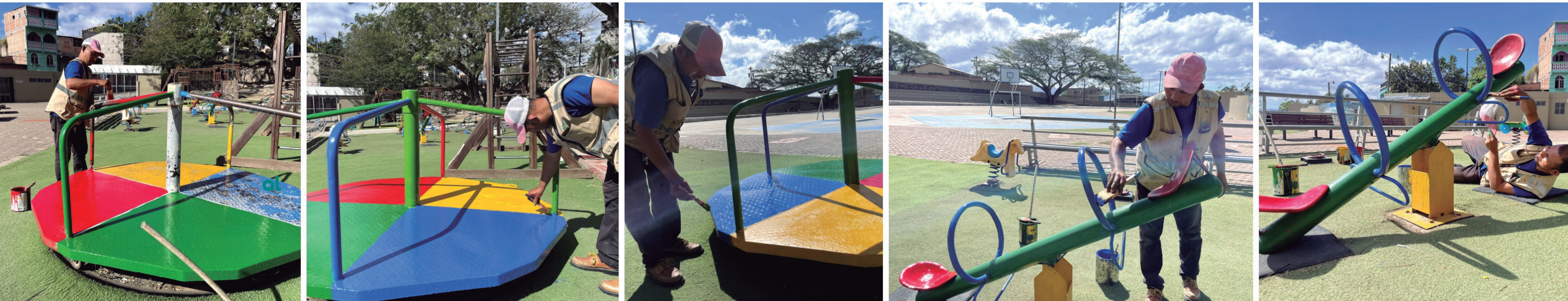
Se ha realizado el lijado y pintado del sube y baja y de la rueda giratoria del Parque Mi Esperanza, Campo Cielo.
