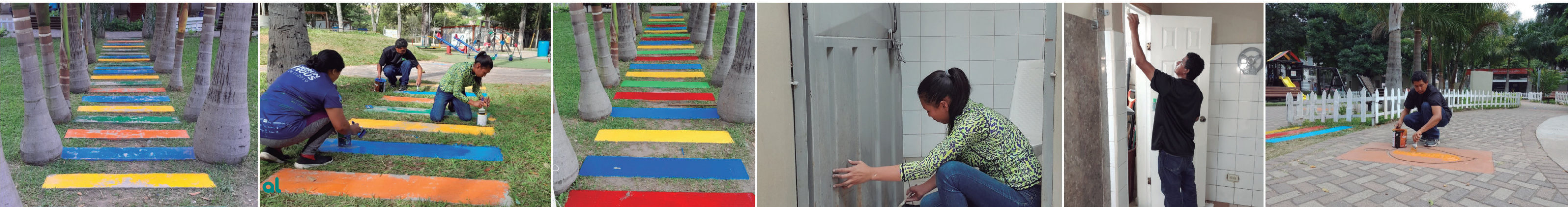
Se ha realizado el lijado y pintado de las huellas y puertas de los baños del Parque San José de La Vega.
