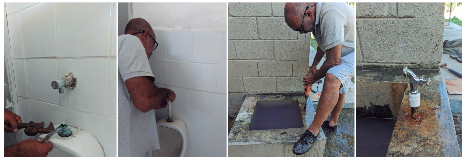
Se realizó la instalación de llave para la pila de agua y la reparación del urinario en el Parque Chamelecón.
