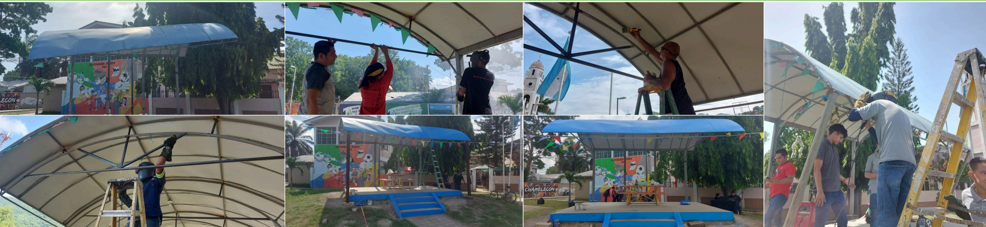
Se reparó, lijó y pintó el techo del área artística del Parque Chamelecón.
