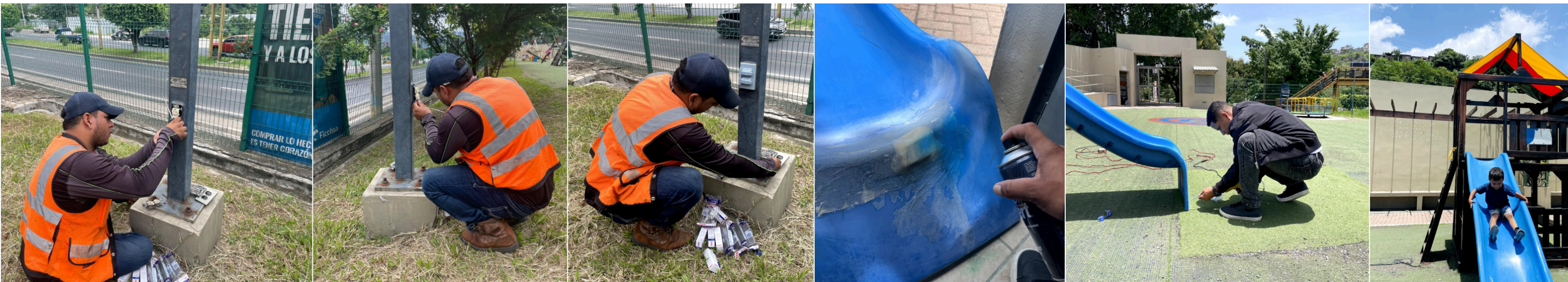
Se cambiaron todos los tomacorrientes y se reparó el deslizador del área infantil del Parque San Francisco.
