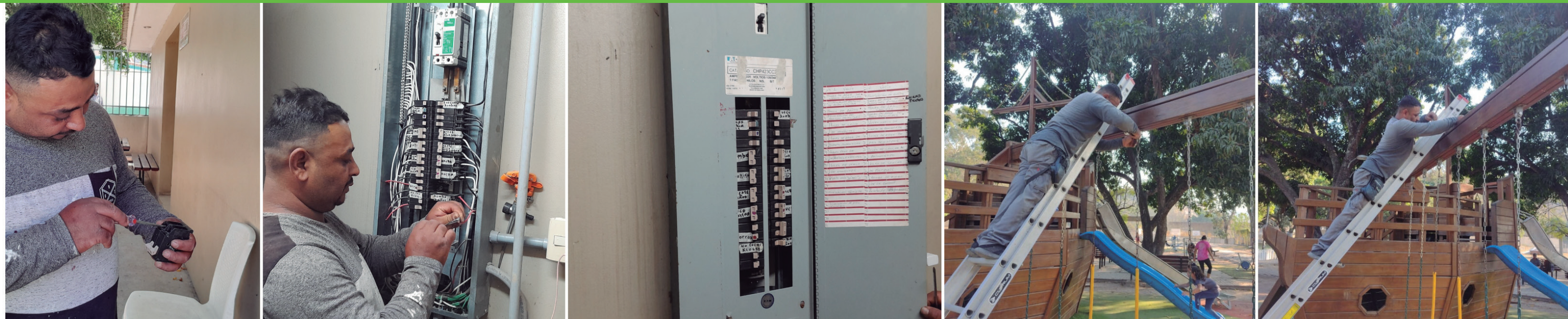
Se reparó el panel eléctrico y algunos columpios del Parque San José de La Vega.
