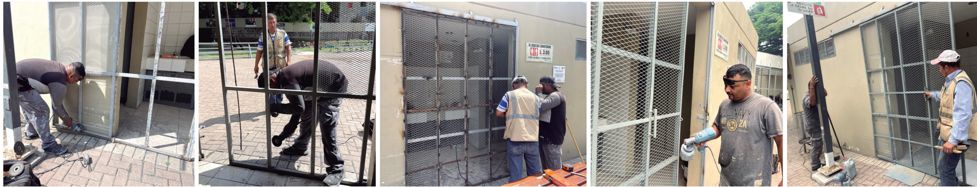
Se reparó y reforzó el pontón principal de los baños del Parque Campo Cielo.
