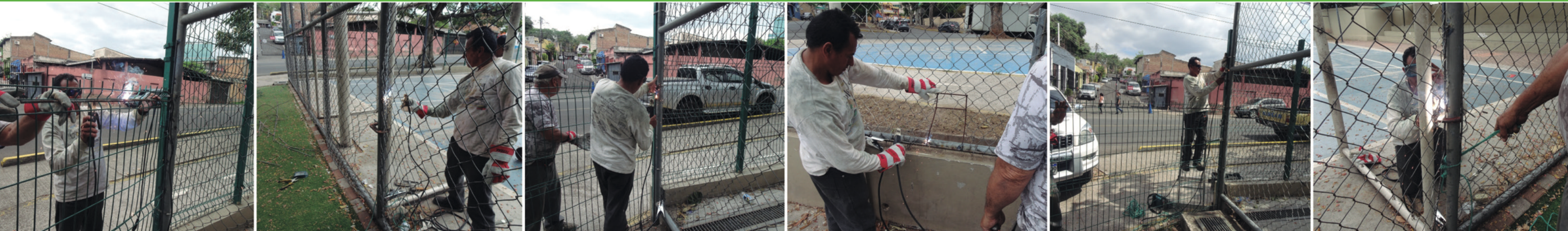
Se repararon las mallas dañadas y parte del cerco perimetral del Parque El Hogar
