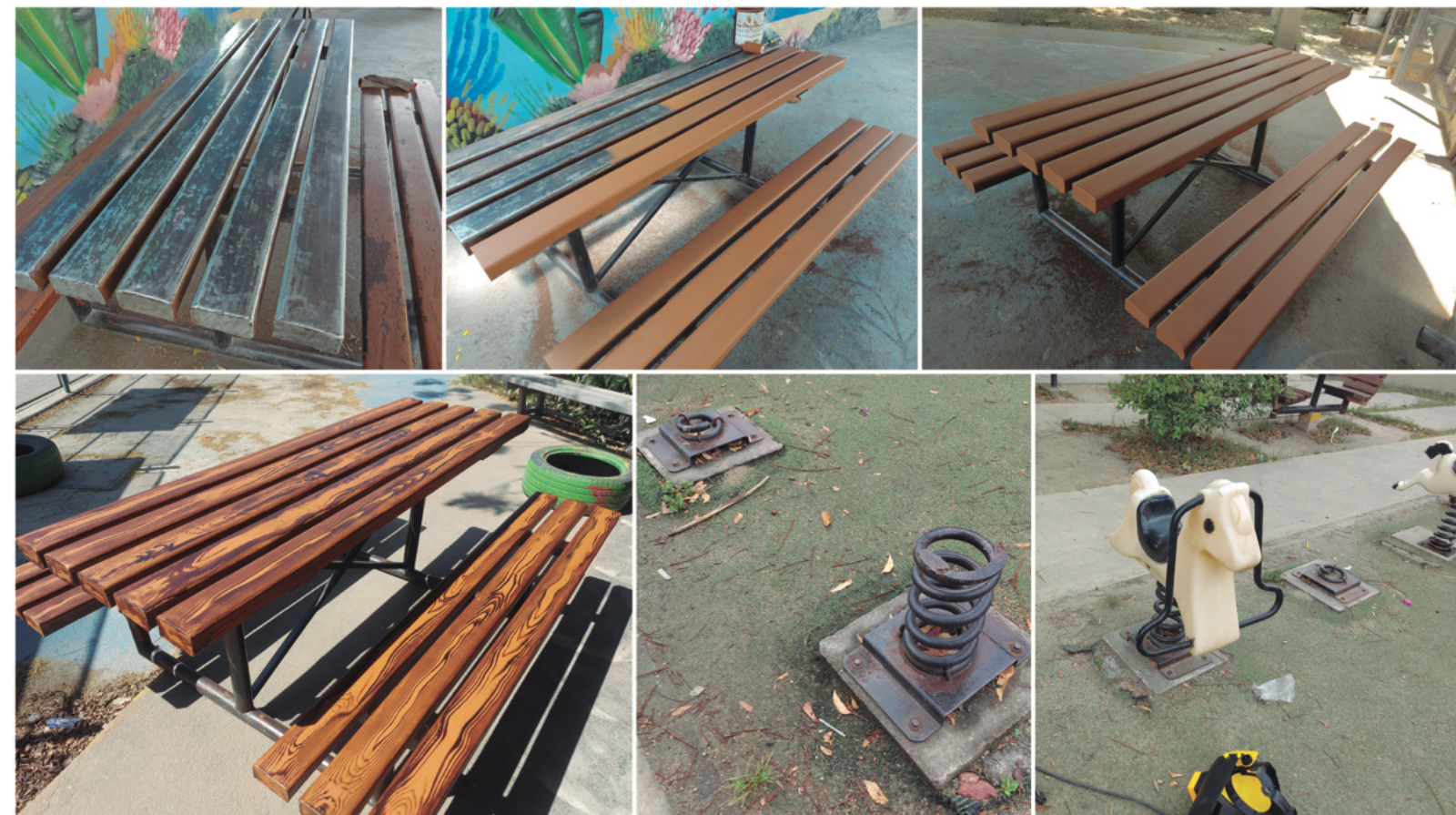
Lijado y pintado de las mesas de picnic y reparación de caballitos en el Parque Rivera Hernández.
