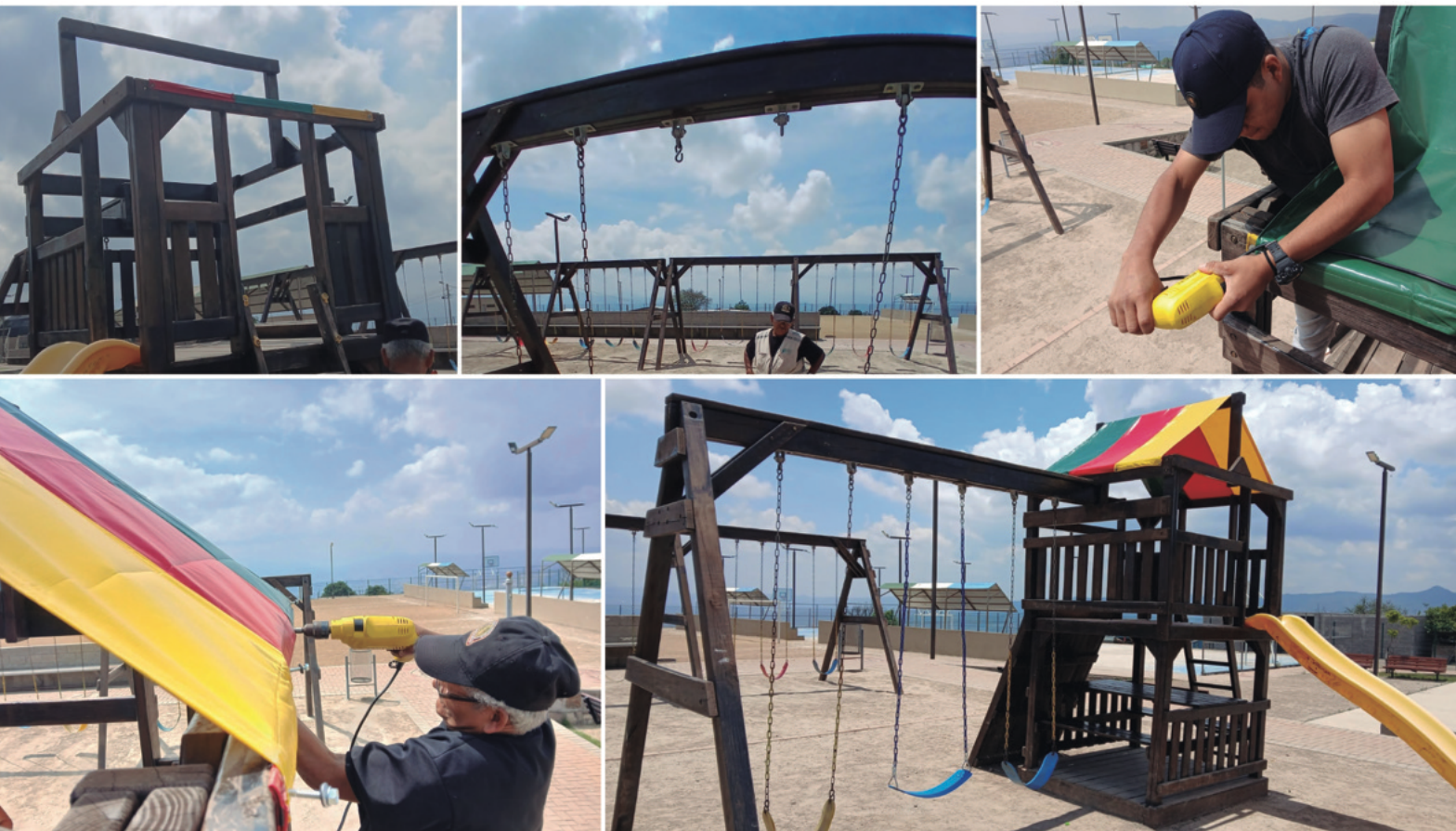
Instalación de columpios y lonas en el single tower del Parque Altos de La Laguna
