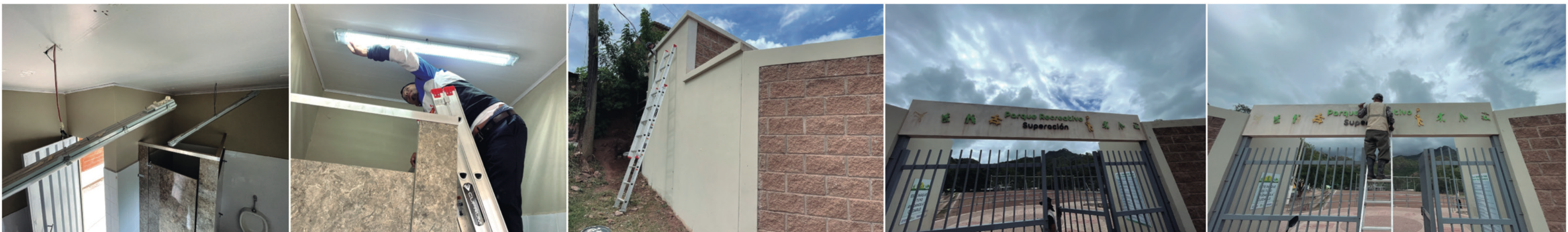
Se realizó el mantenimiento de la iluminación en los baños, se pintó el muro perimetral y la fachada del Parque Nueva Suyapa.
