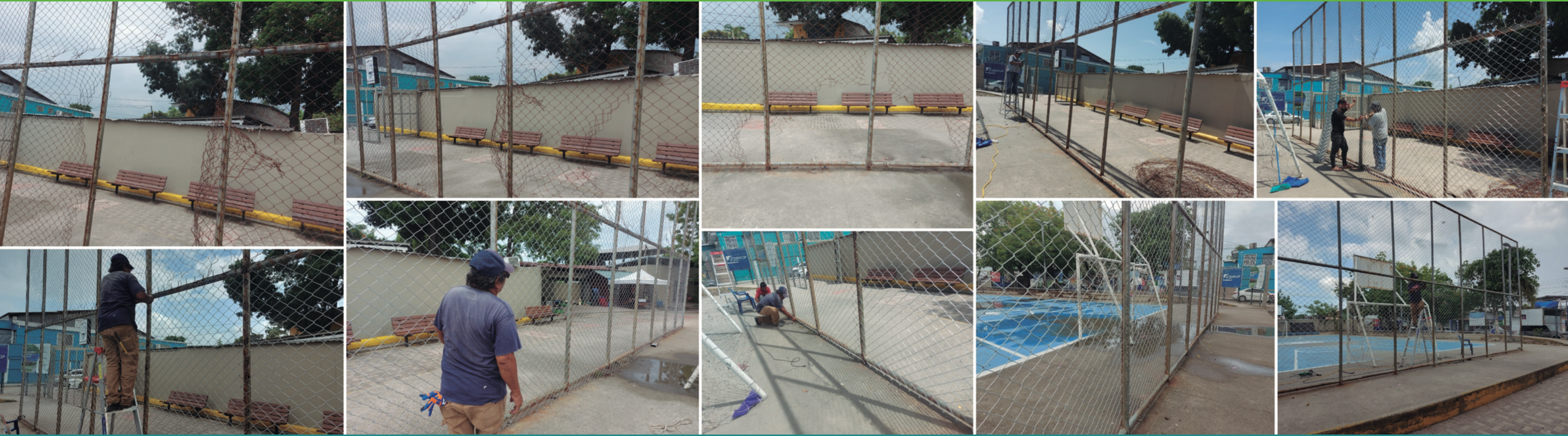
Se reemplazó la malla dañada en el cerco perimetral de la cancha deportiva del Parque Rivera Hernández.
