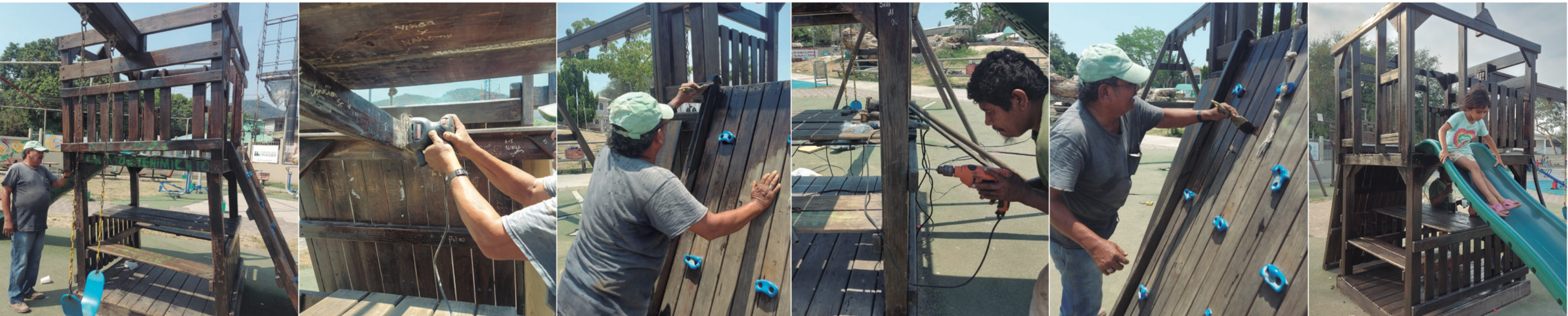
Se hizo la reparación, lijado y pintado del single tower del Parque Chamelecón.
