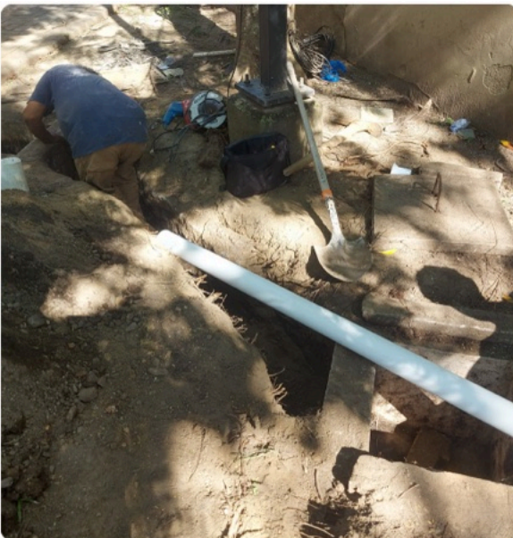
Reparación de caja de registro de aguas lluvias del Parque Alegría en el El Progreso, Yoro
