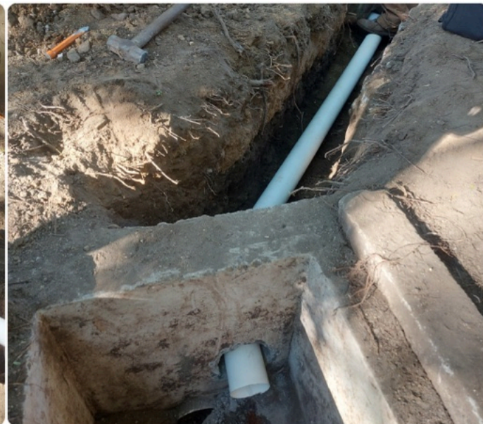
Reparación de caja de registro de aguas lluvias del Parque Alegría en el El Progreso, Yoro
