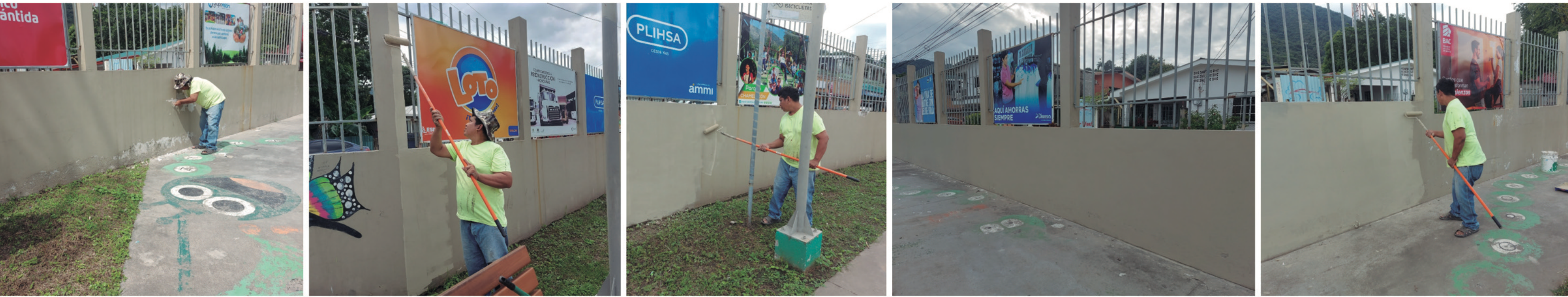
Lijado y pintado de todo el muro perimetral del Parque Chamelecón.
