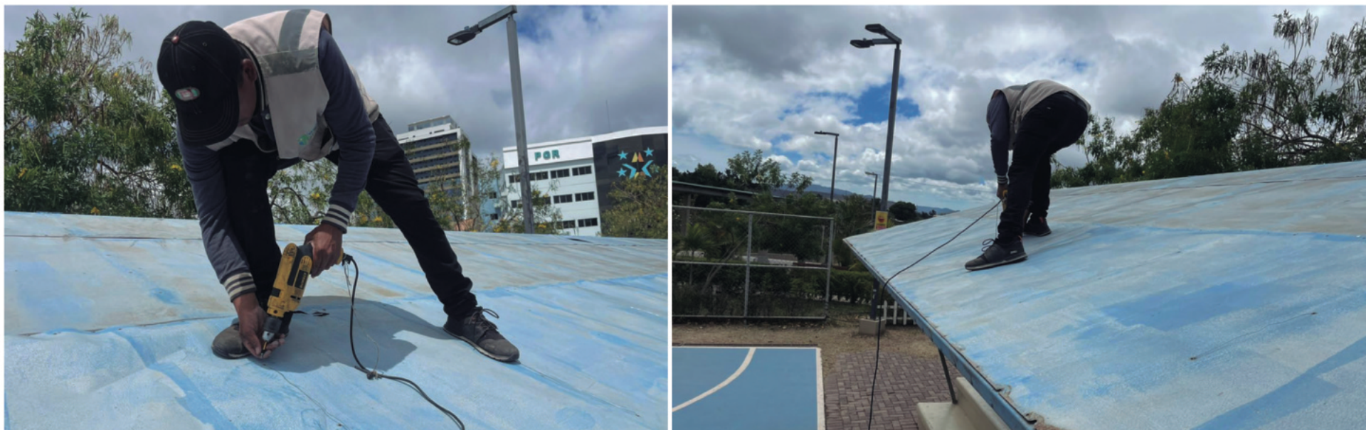
Reparación del techo de la cancha multiusos del Parque El Trapiche.
